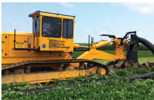
Рис. 29.1. Робота кротодренажної машини із закладання труб
